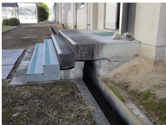
階段を2段継ぎ足すぐらいの沈下です。ひび割れ、壁のはがれなど、とても学校だけでは対応しきれないと思うのです。
