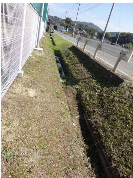
校舎とグラウンドの間に設置された排水溝も一部沈下していることや、高低差によって雨に流される砂がたまり、堆積していますが、校庭の外への排水も、排水口がつまるほど流された土砂が堆積していて水をせき止めています。
